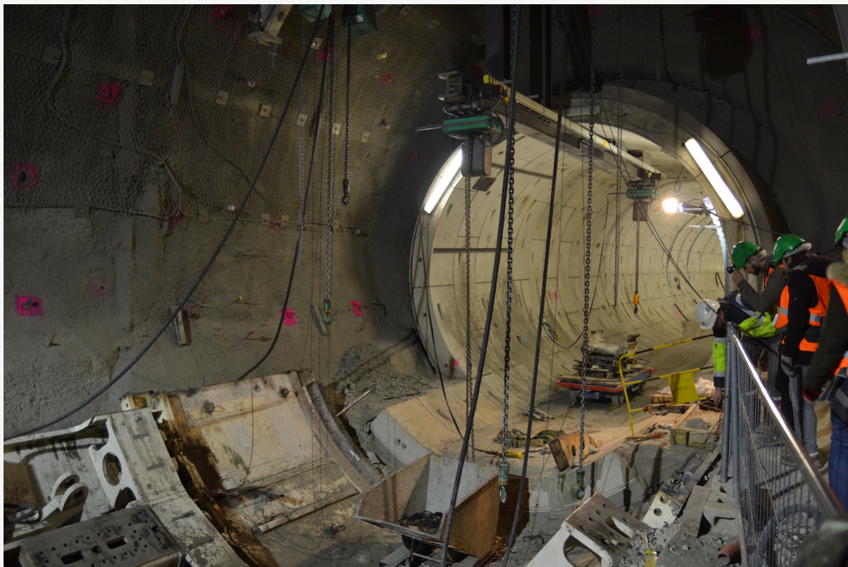
Le chantier de construction de Cigéo, en mars 2018.
