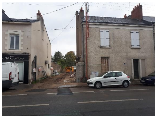
La démolition des annexes de la maison est en cours ...
