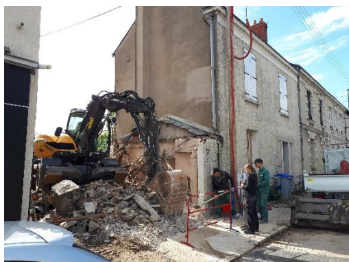
Le poteau électrique est déplacé ...
