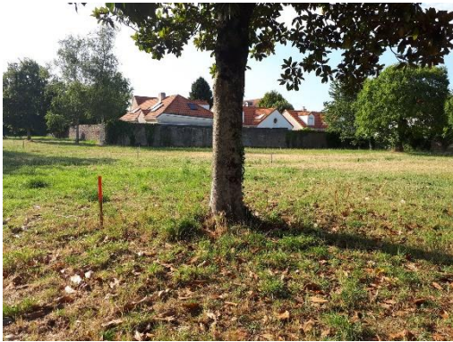
Implantation des bâtiments par des piquets colorés ...
