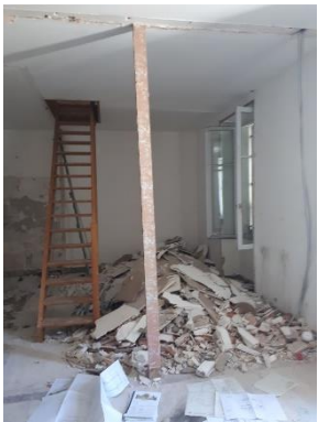
Démolition intérieure de la maison existante
