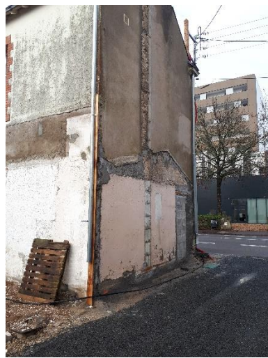
Finition de la démolition de la maison
