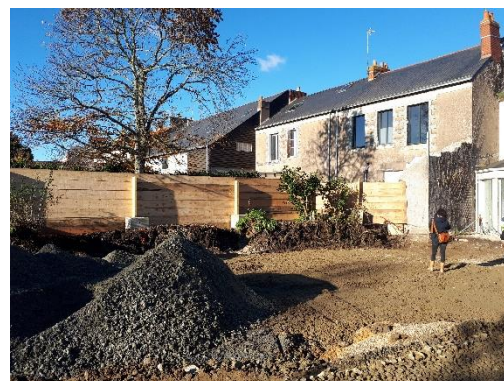
Démolition du mur mitoyen au droit du Bâtiment E et mise en place d'une clôture bois
