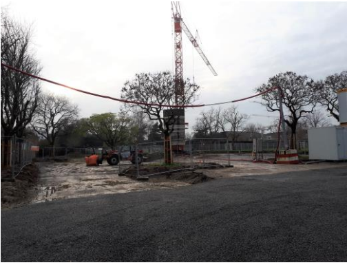
Installation de la grue et de la base vie
