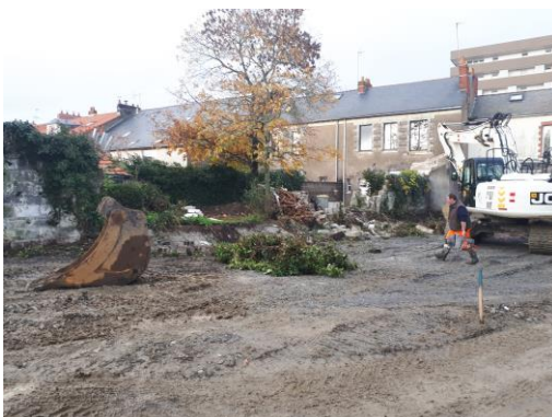
Démolition du mur mitoyen au droit du Bâtiment E et mise en place d'une clôture bois
