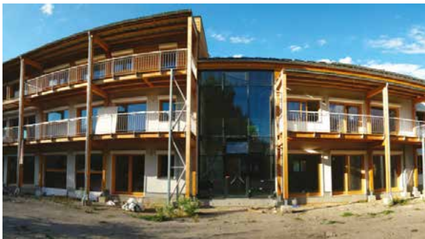
SCIA Habrico à Briançon, installation en 2016.
