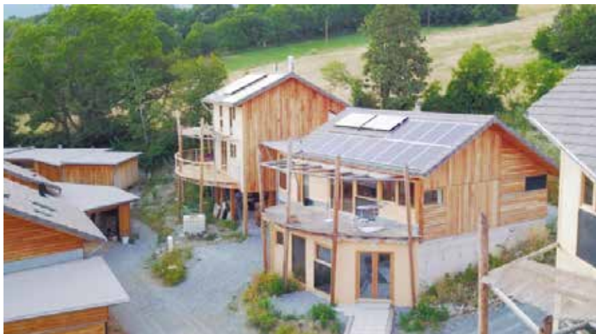
SCIA Les Allouiers à Gap, installation en 2016.
