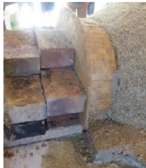
Monter les bords avant le centre
