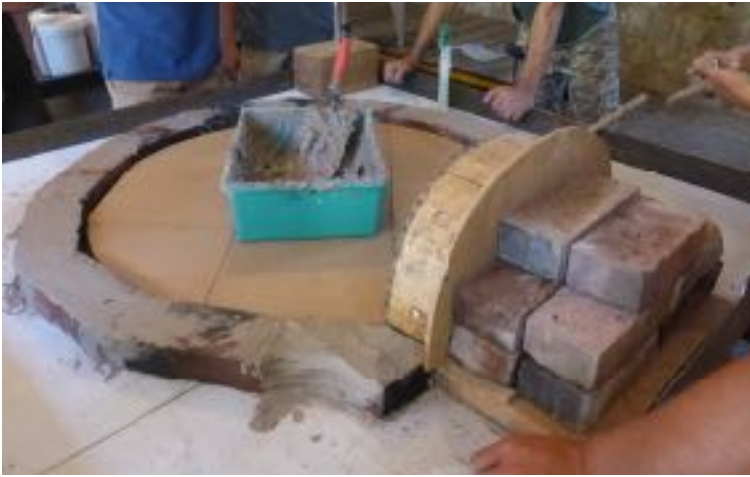
Humidifier les surfaces à coller
