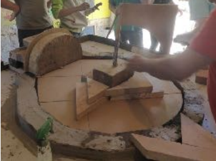
Monter les bords avant le centre
