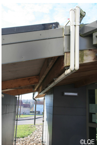
Liaison capteurs - ballon
