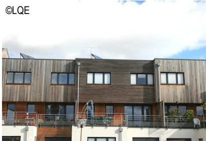
3 maisons individuelles accolées à Saint-Max (54)
