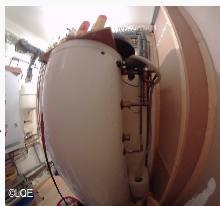
Ballon et réservoir de collecte en cas de déclenchement de la soupape de sécurité
