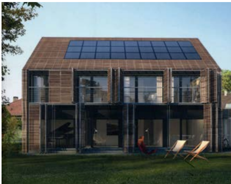
Construction d'une maison passive à Bessancourt, architectes M. Karanesheva et M. Witzmann Les capteurs solaires, thermiques et photovoltaïques sont intégrés en toiture dans un traitement homogène.
