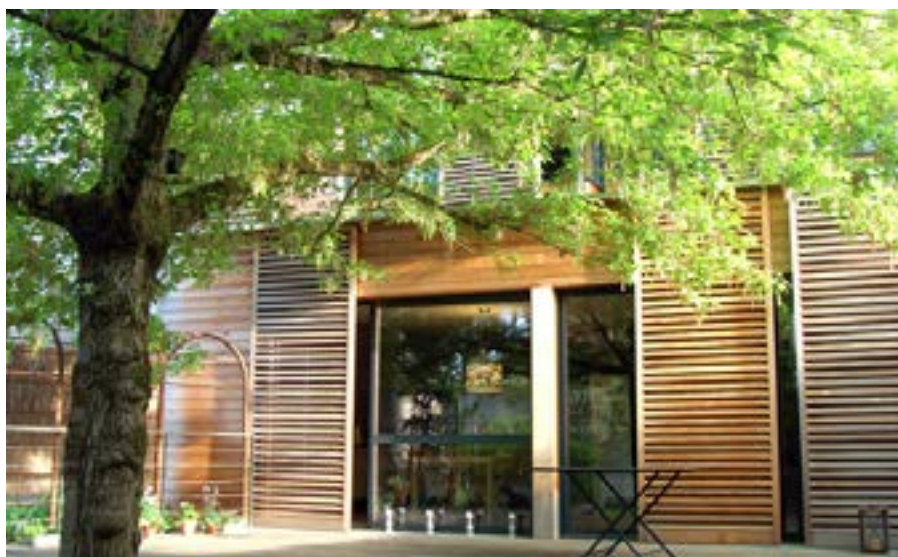
Extension à Angers (49), architecte Pascale Minier
