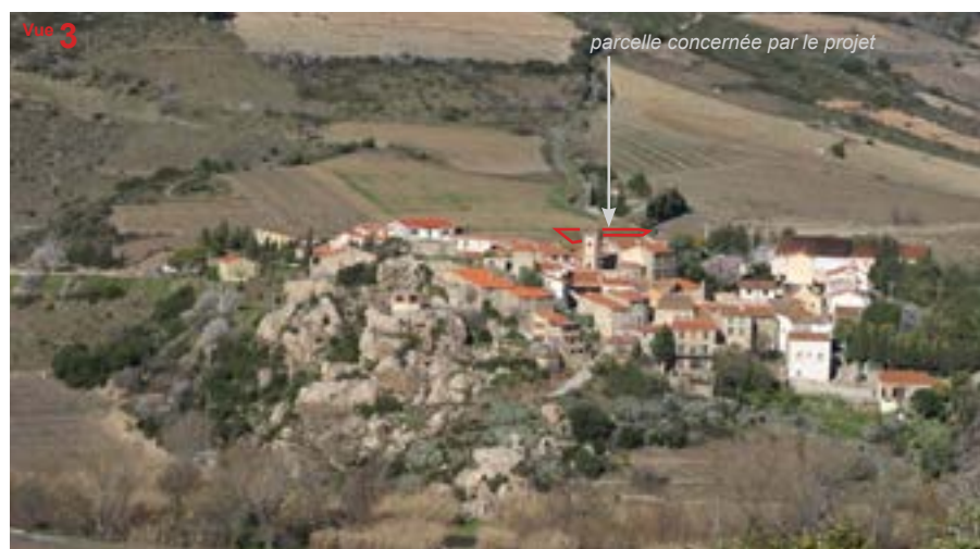
Depuis la route venant de l'Ouest, le village ancien et ses premières extensions sont complètement masquées : ce versant exposé au vent n'a pas été bâti et sert de protection naturelle aux constructions.
