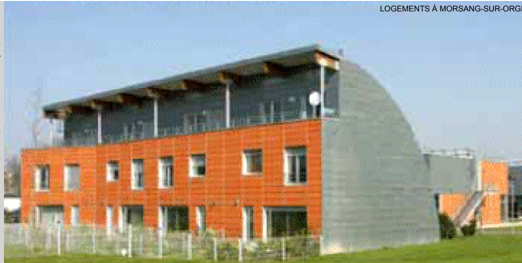
LOGEMENTS À MORSANG-SUR-ORGE
