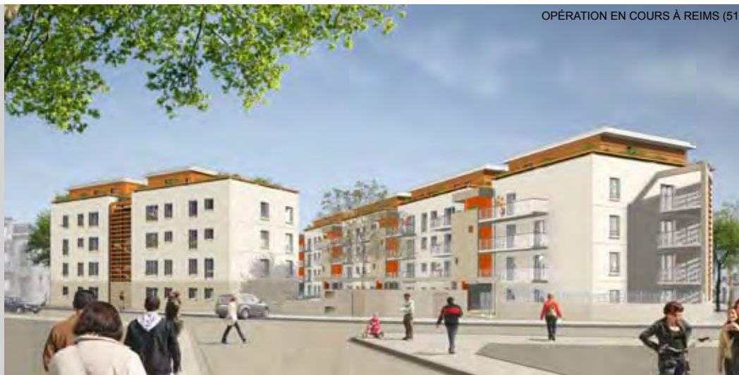
OPÉRATION EN COURS À REIMS (51)
