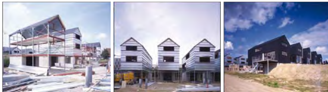
MISE EN OEUVRE DES 26 MAISONS DE CHANTEPEIE (35)
