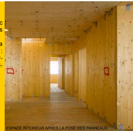
ESPACE INTERIEUR APRES LA POSE DES PANNEAUX
