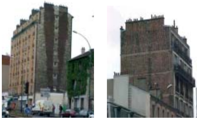
Figure 5.7 : conduits de fumée individuels
