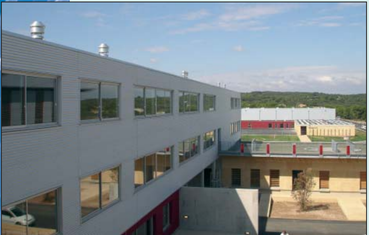
Lycée Jean-Vilar à Villeneuve-lès-Avignon (30)
