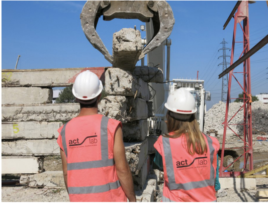
Dépose de poutres en béton sur le site de ActLab
