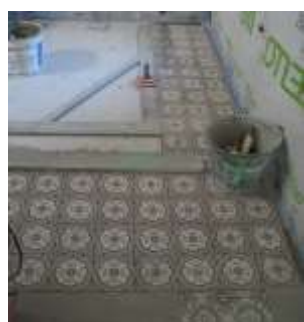
Récupération des carreaux ciment
