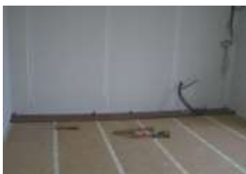
Récupération du parquet
