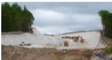
Vue du principal déblai crayeux en cours de terrassement
