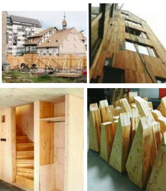
Palissade et façade (haut) ; Escalier construit à partir des chutes de l'ossature (bas)
