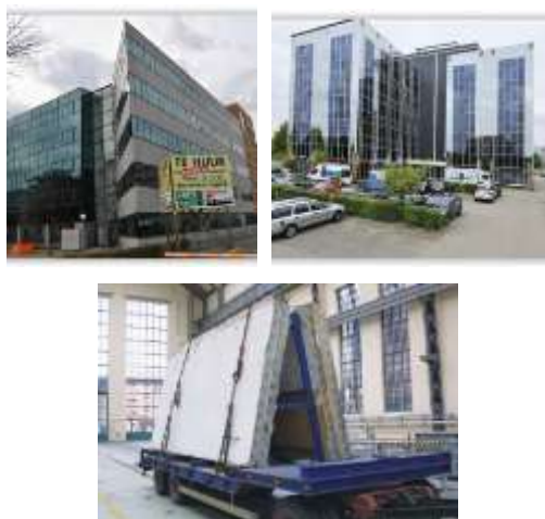
Bâtiments déconstruits (haut) ; dalles alvéolées (bas)
