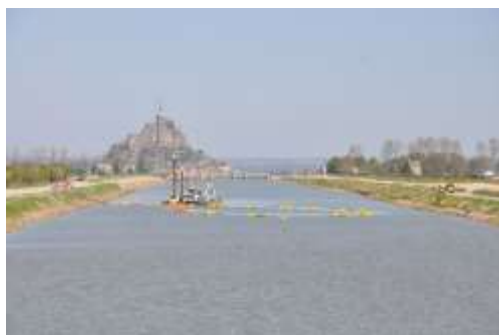
Chantier de dragage
